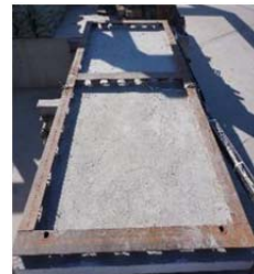
新型楼板浇筑混凝土
