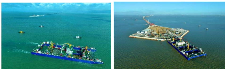
自航式沉管浮运安装一体船施工图
