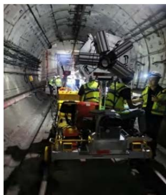
隧道病害检测移动扫描测量
