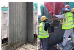
钢管束安装、内灌混凝土
