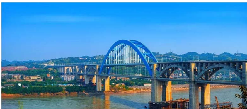
成贵铁路宜宾金沙江公铁两用桥实景
