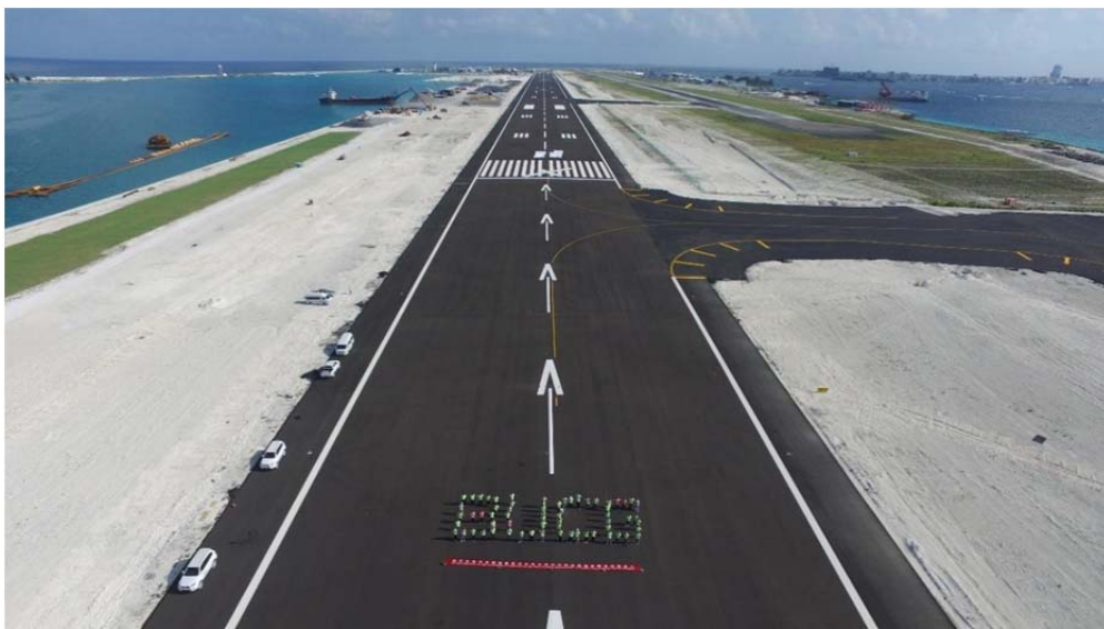
图2 扩建机场跑道完成图
