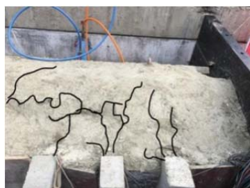
后桩前缘坡体局部破坏
