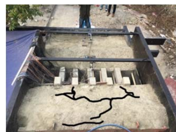
前桩后缘坡体开裂破坏
