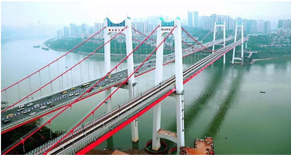
鹅公岩轨道专用桥（右）与既有鹅公岩公路大桥（左）
