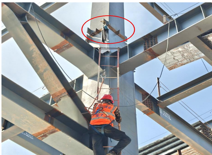
(a) 上下爬梯应将速差防坠器与安全帶相连
