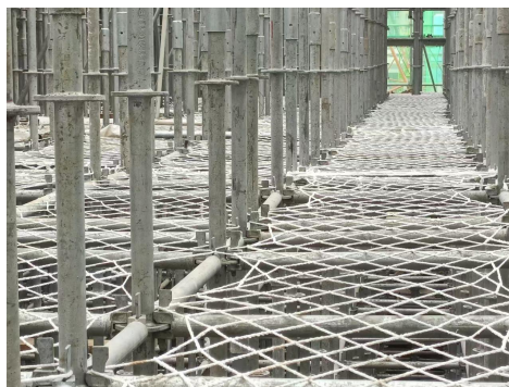
图 8 支模架搭设过程中防坠安全平网
