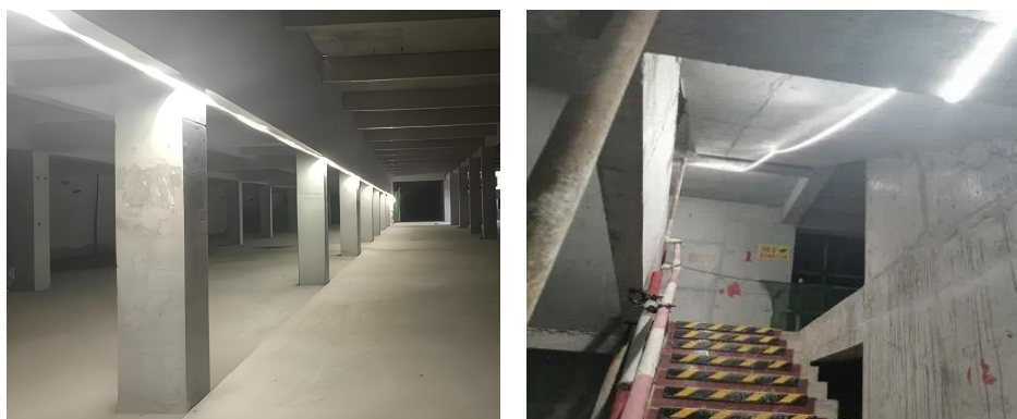
图 4 施工临时照明
